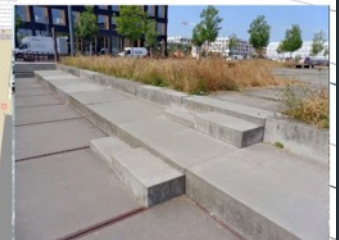
3- Des gradins et marches en béton préfabriqué gris sur mesure
